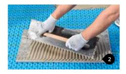
Appliquer du ciment-colle au dos des carreaux à l'aide d'une truelle dentelée puis les étendre sur la couche de ciment-colle préalablement appliquée. Retirer et vérifier certains carreaux occasionnellement afin de confirmer une adhérence complète.
